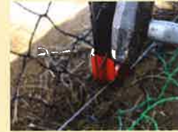
【④フックを打込む】
